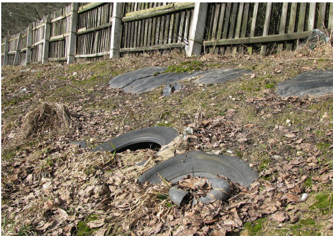
Drenaż z opon i geomembrana HDPE widoczne na obwałowaniu składowiska (03.2009 r.)
